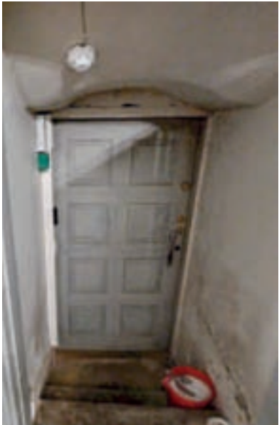
Sakastin ulkoovi ja porras sisäpuolelta (NAC Arkkitehdit, 2025)
