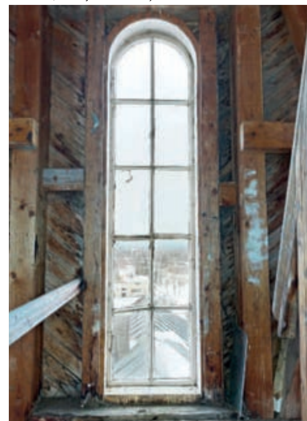
Kirkkotornin ikkuna sisäpuolelta, näkymä etelään (Kuvakaappaus matterport-skannauksesta, Vähänkyrön kirkko, A-insinöörit, 2025)
