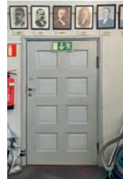
Sakastin väliovi sisäpuolelta (NAC Arkkitehdit, 2025)
