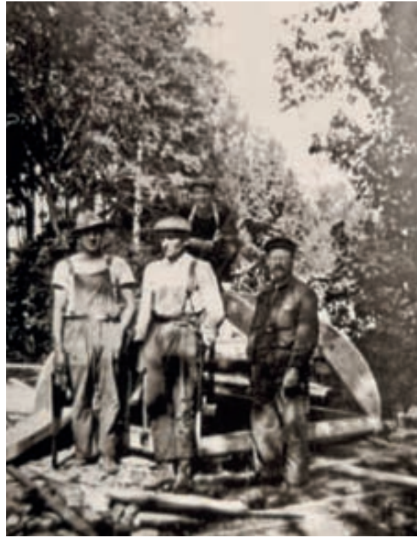
Tornin huippua rakennetaan kirkkopihasa 1937, Takana Arvo Jaaksi, Vas. Reino Välimaa, oik Jaakko Lehtiö (Vähäkyrön seurakunnan arkisto, kuvaaja tuntematon, 1937)
