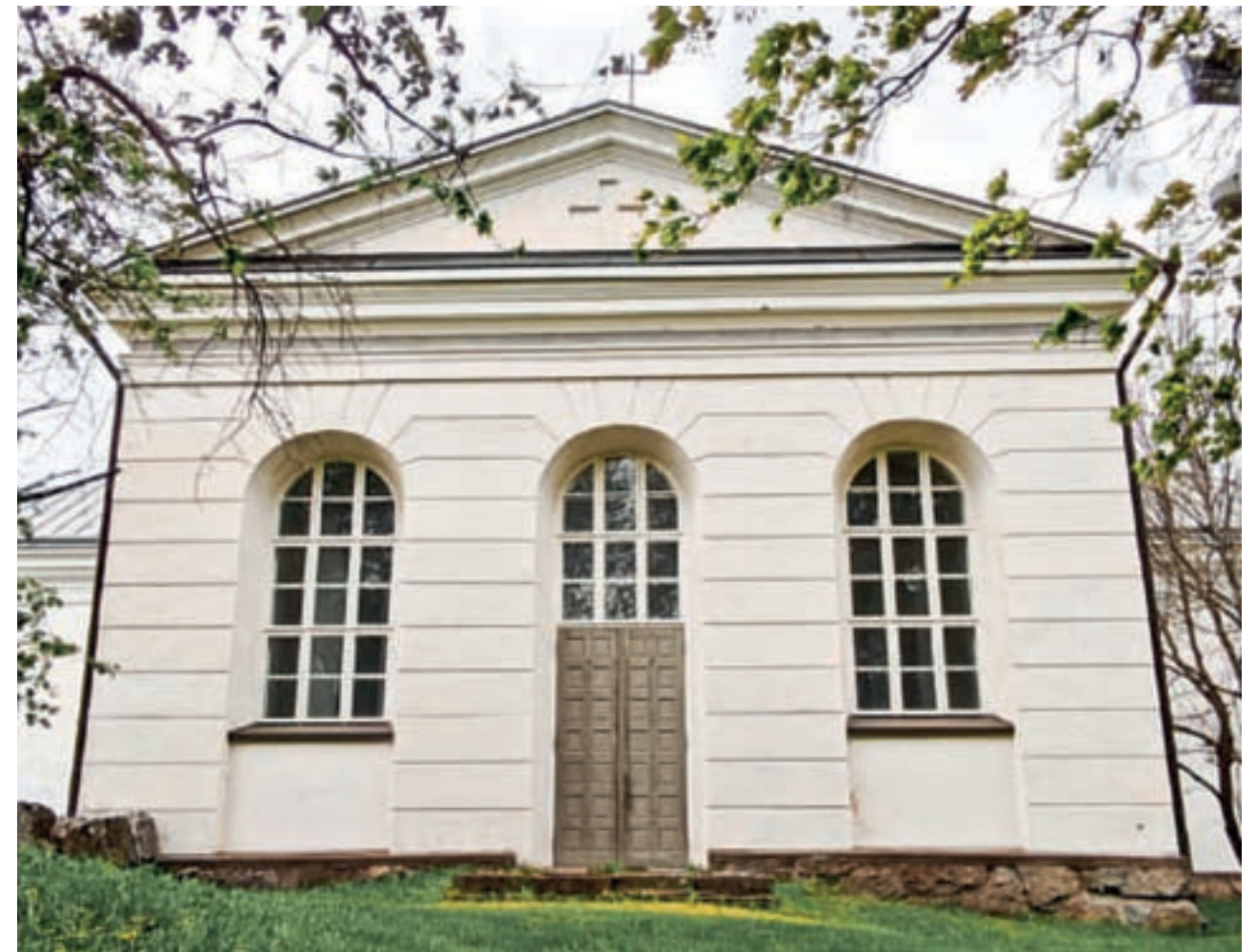
Pohjoisen sisäänkäynnin kiviportaavat ovat pienemmät kuin muut (NAC arkkitehdit, 2025)
