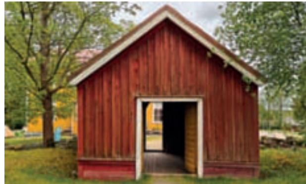
Porttirakennus (NAC Arkkitehdit, 2025)
