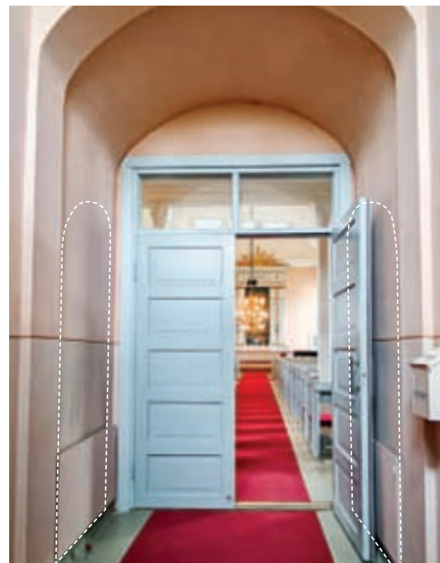
Kuvassa vanhojen porrashuoneiden aukkojen sijainti. (NAC arkkitehdit, 2025)
