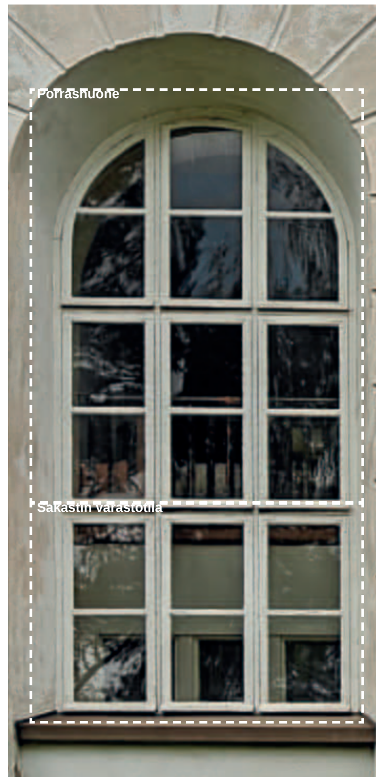
Ikkuna itäjulkisivulla (NAC Arkkitehdit, 2025)
