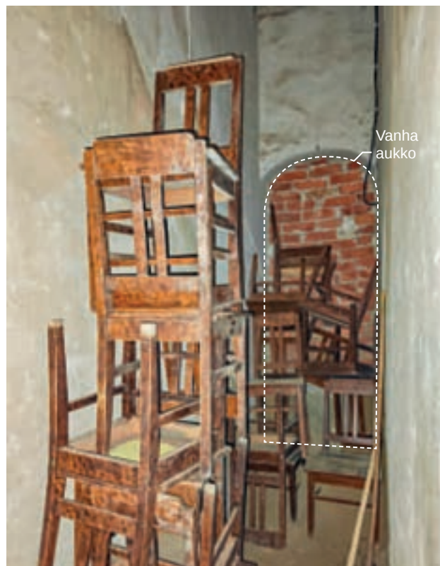
Aukko vanhaan porrashuoneeseen on muurattu kiinni, kuva nykyisen betoniportaan vierellä olevan varastotilan sisäpuolelta (NAC arkkitehdit, 2025)
