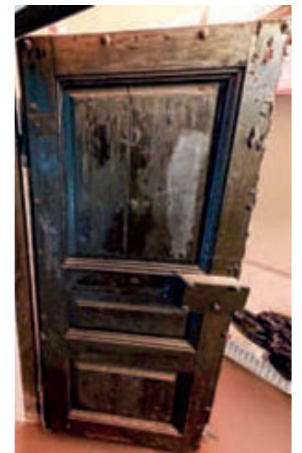
Toisessa varastotilassa oleva sisäovi, mikä johtaa vanhaan holviin (NAC Arkkitehdit, 2025)
