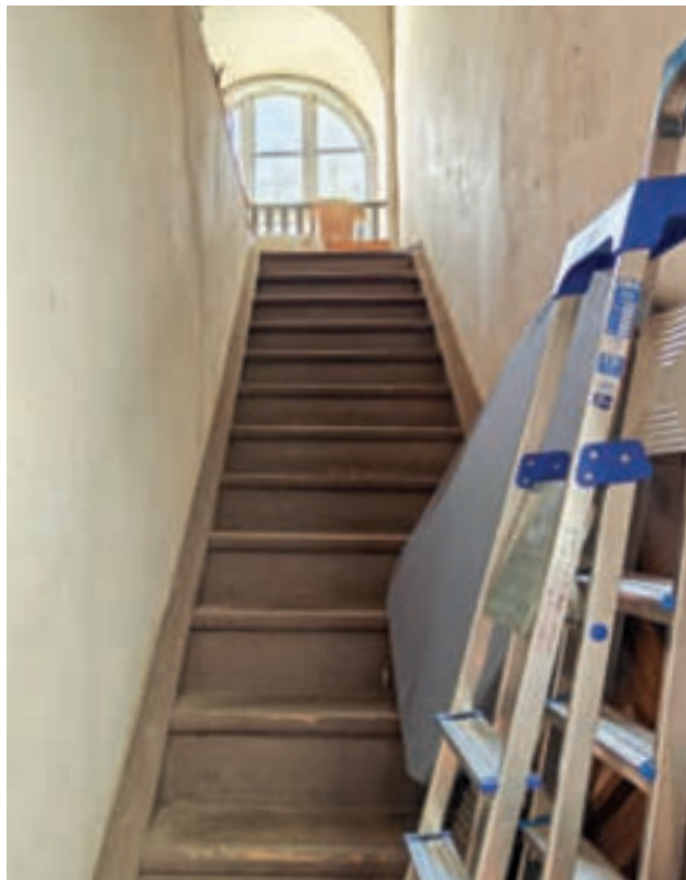
Vanha puuportaikko altтарin takana (NAC arkkitehdit, 2025)
