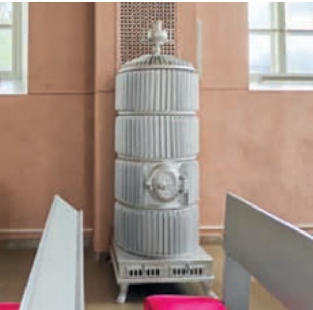
Kirkkosalin kamina (NAC Arkkitehdit, 2025)
