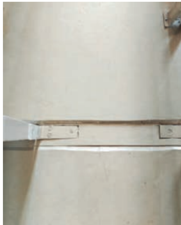
Penkkien kiinnitys lattiaan (NAC Arkkitehdit, 2025)
