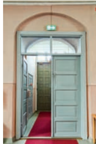
Eteisen väliovi kirkosalilta (NAC Arkkitehdit, 2025)
