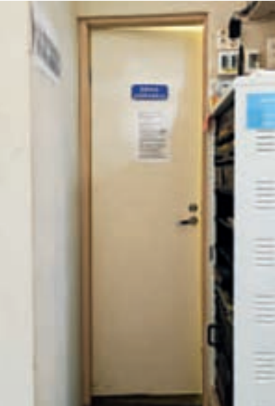
Sähköpääkeskukseen johtava ovi (NAC Arkkitehdit, 2025)
