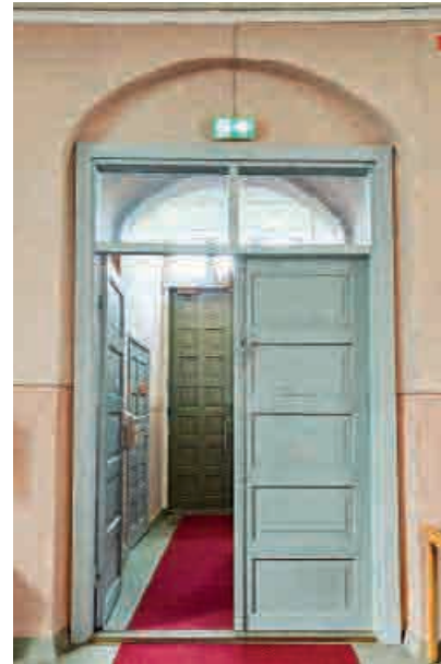
Eteisen väliovi kirkosalilta
