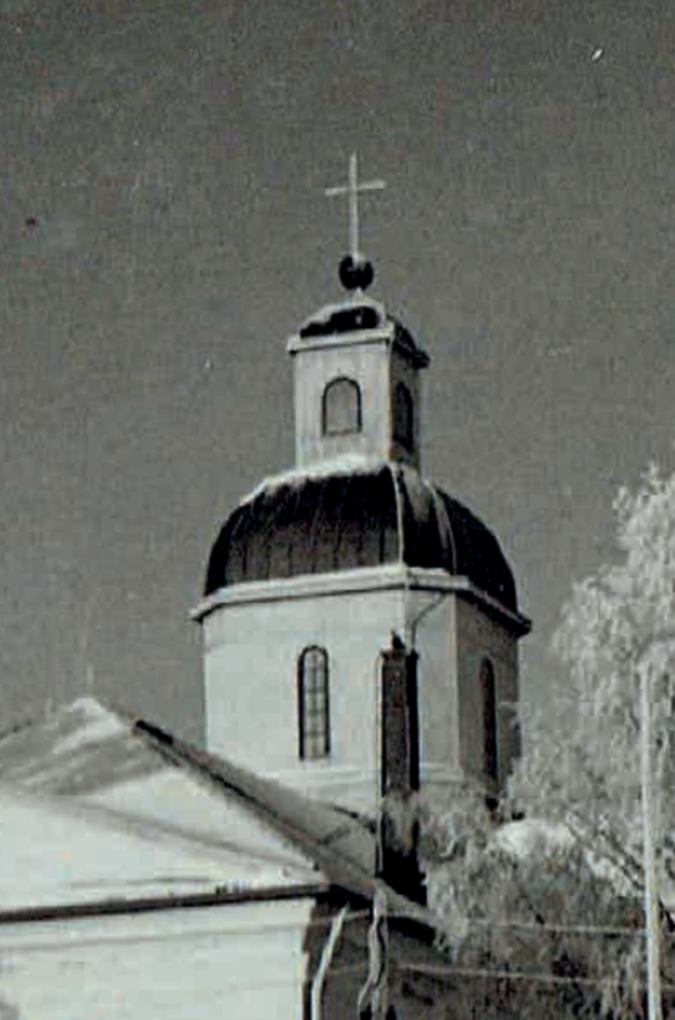
Kirkkotornin ikkunat oli tummaruskea sävy vuoden 1965 julkisivun remontin ennen, Lähde:
