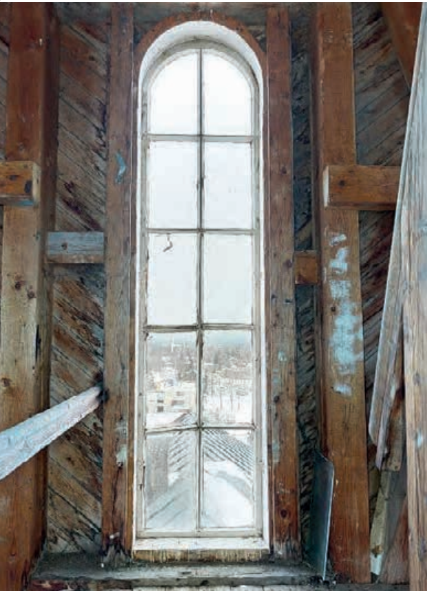
Kirkkotornin ikkuna sisäpuolelta, näkymä etelään
