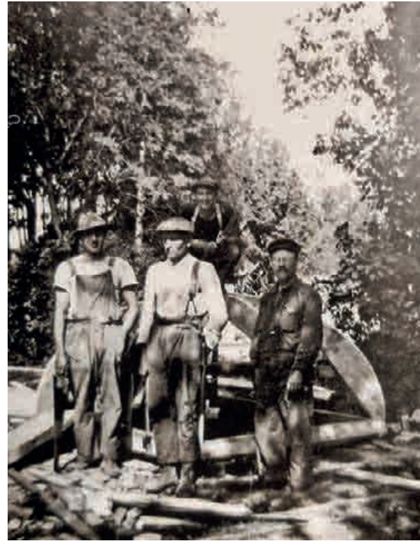
Tornin huippua rakennetaan kirkkopihassa 1937, Takana Arvo Jaaksi, Vas. Reino Välimaa, oik Jaakko Lehtiö Lähde: Vähäkyrön seurakunnan arkisto
