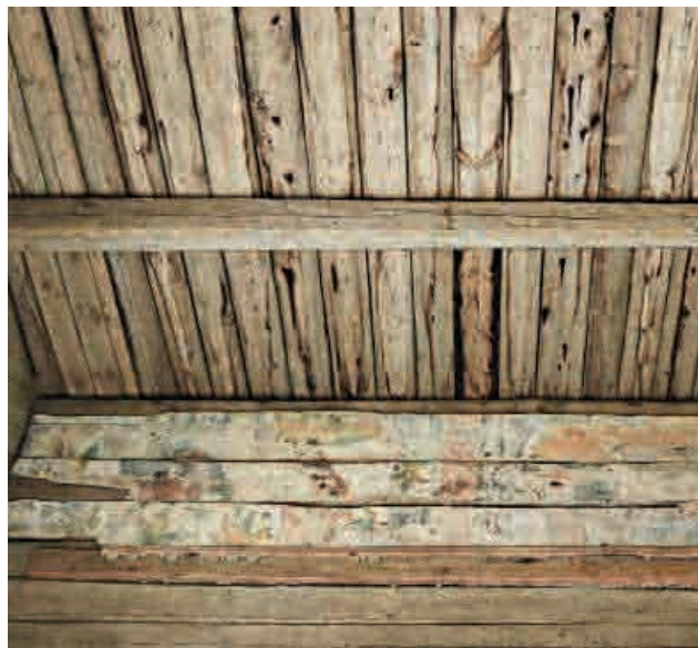
Porttirakennuksen sisäseinä, Lähde: NAC arkitehdit
