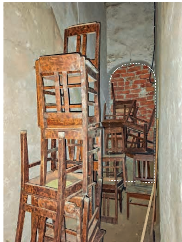
Muurattu kiinni aukko vanhaan porrashuoneeseen, nykyinen betoniportaan vierellä oleva varastotilan sisäpuolelta
