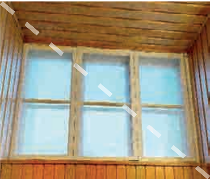
Odotushuoneen ikkuna. Yläosa on urkuparvekkella urun sisällä.
