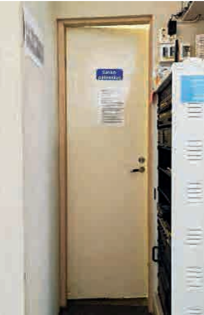
Sähköpääkeskukseen johtava ovi
